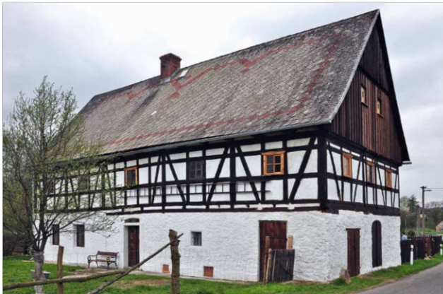
Obr. 67: Pertoltice – okres Liberec, dům čp. 198 – původně čp. 12 (foto J. Pešta, 2013).
